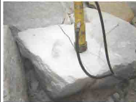
Образование трещин
